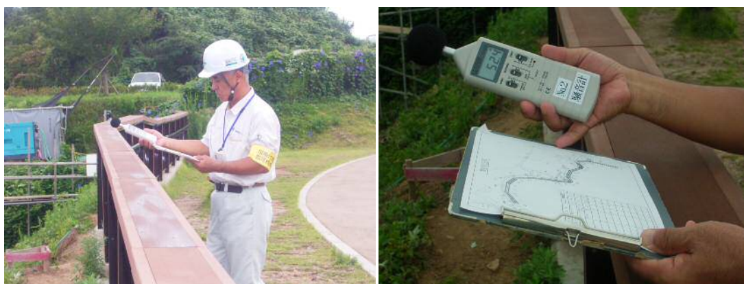
写真2. 防音対策と騒音モニタリングの状況
