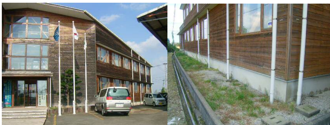
写真4. 雨どいからの雨水を地下タンクに導入しています
