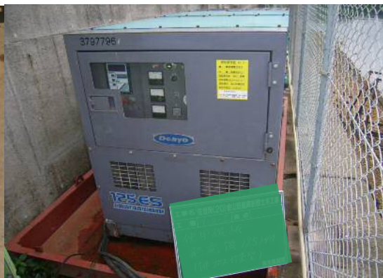
写真5. 燃料油漏洩防止パレットの設置
