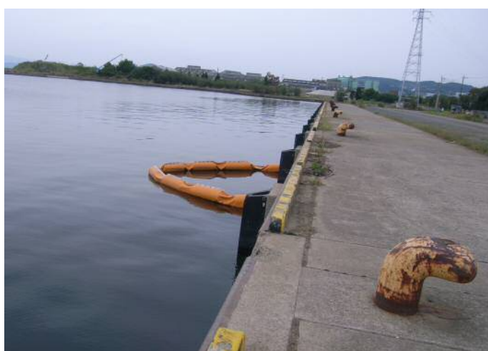
写真7. 海洋汚染防止のための濁水防止膜の設置
