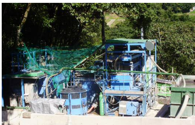
写真6. トンネル掘削工事における濁水処理プラント
