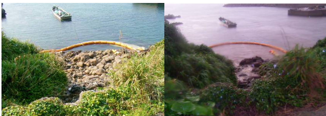
写真7．海洋の汚濁防止膜の設置状況（右の写真は降雨時の模様） 切土法面からの降雨による泥水の流入防止を行いました
