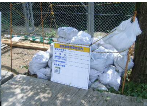
写真 1 5．舗装のハツリガラは土嚢袋に入れ分別保管
