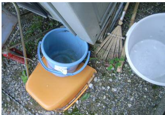
写真 1 4．現場事務所の雨だれを集め、右のバケツへ入れ雑水として利用
