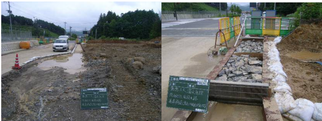
写真6．切り土部から発生する濁水を仮設のろ過槽へ導きろ過の後排水（ろ過設備は舗装路上部に H 鋼を使用して作製）
