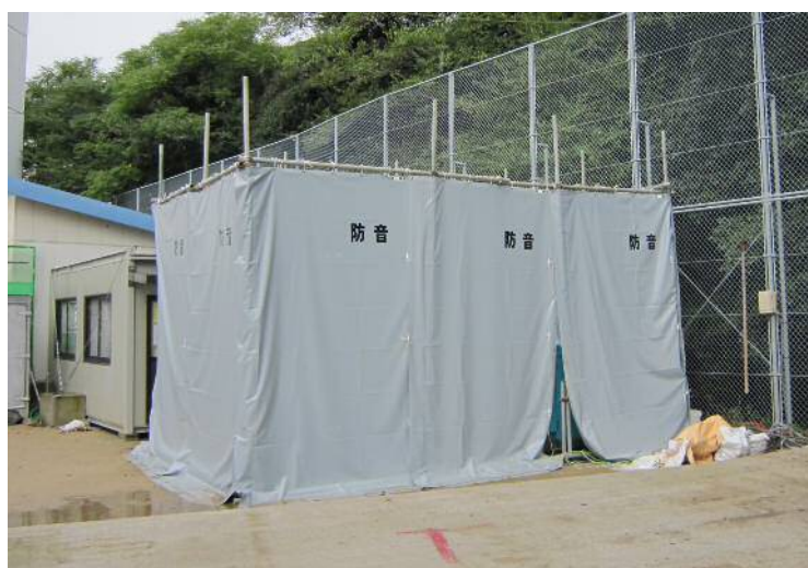
写真 9．法面吹付け用コンプレッサの防音対策
