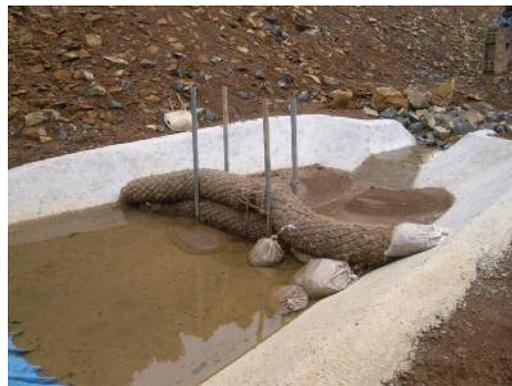
写真6. 切り土部から発生する濁水を仮設ろ過槽へ導き、ろ過して排水しています。
