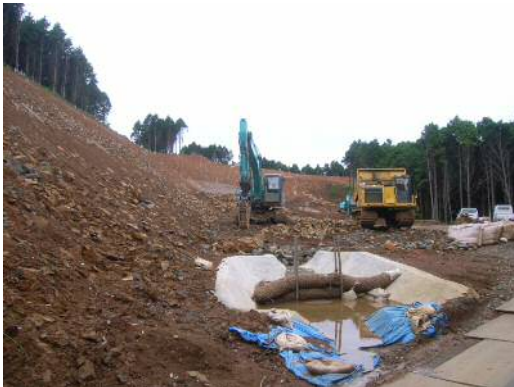
写真1. 切り土部から発生する濁水を仮設ろ過槽へ導き、ろ過して排水しました。
