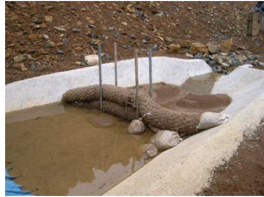
写真1. 切り土部から発生する濁水を仮設ろ過槽へ導き、ろ過して排水しました。
