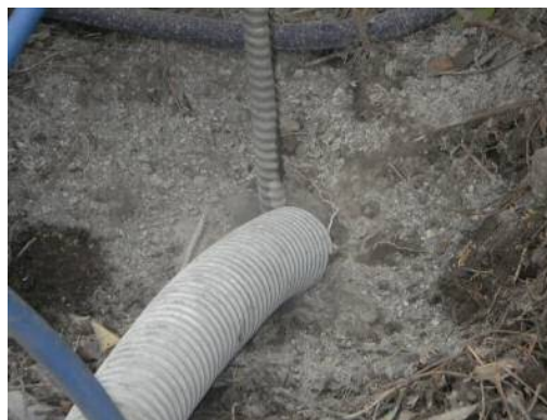
写真 5. さく岩機による削孔時の粉塵を低減するため、粉塵が発生する孔口から集じん機により吸引を行いました。民家に近接した施工現場でしたが、粉塵発生をかなり抑制して施工することが出来ました。
