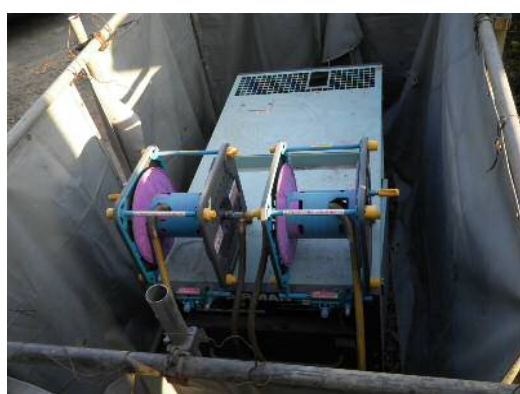
写真 6. 民家に近接した施工現場であったため、さく岩機作動用のコンプレッサーを防音シートで囲み、騒音対策を行いました。
