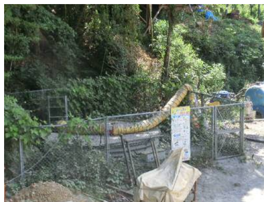
写真 11. 真夏の地滑り対策現場において既設の集水井戸内の空気を休憩所へ送風し冷房設備の代替としました。
