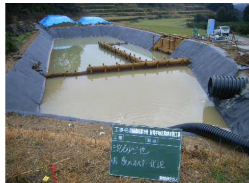
写真2. 当現場下流側の海には魚の養殖場があったため、掘削面から発生する濁水処理を行うため、確実に濁水を集め処理槽に送る配管を設置し、処理槽を3槽に分け、二度ろ過を行って排水するなどの万全の対策を実施しました。
