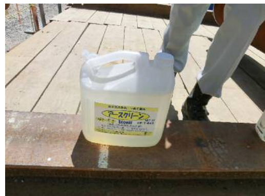
写真4. エアハンマー用潤滑油として生分解性油を使用しています。
