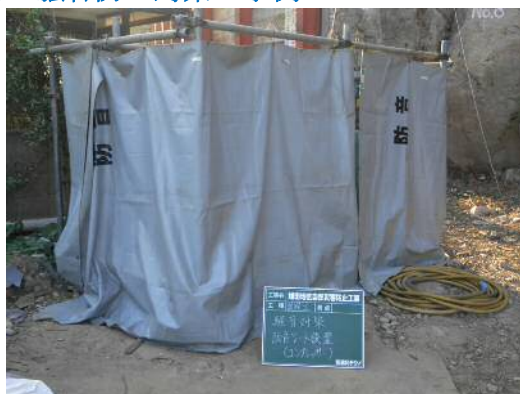
写真 6. 民家に近接した施工現場であったため、さく岩機作動用のコンプレッサーを防音シートで囲み、騒音対策を行いました。
