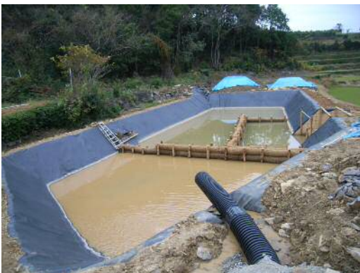
写真2. 当現場下流側の海には魚の養殖場があったため、掘削面から発生する濁水処理を行うため、確実に濁水を集め処理槽に送る配管を設置し、処理槽を3槽に分け、二度ろ過を行って排水するなどの万全の対策を実施しました。
