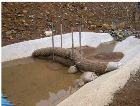
写真 2. 切土からの濁水を防止するため、ヤシマットでろ過膜を設置しました。
