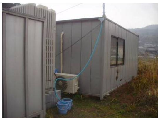
写真 7. 現場事務所の屋根に降る雨水を集め、仮設トイレの用水として利用しました。
