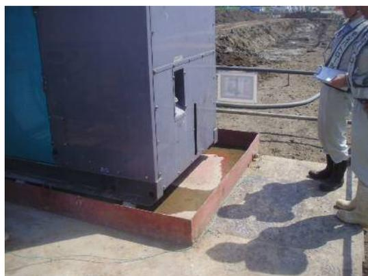
写真 6. 燃料や潤滑油の漏洩防止のため、発電機を防油パレットに設置。
