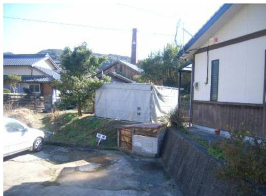
写真 5. 民家に近接した現場では、発電機や施工機械を防音シートで囲んでいます。
