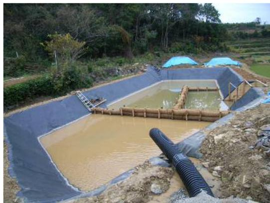
写真 3. 下流側河川の汚濁防止のため、3槽の沈砂池を設置しました。
