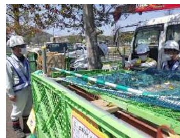
西部幹線 削孔湧水の循環再利用
