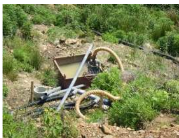
牧の地地区 工事用水に湧水利用
