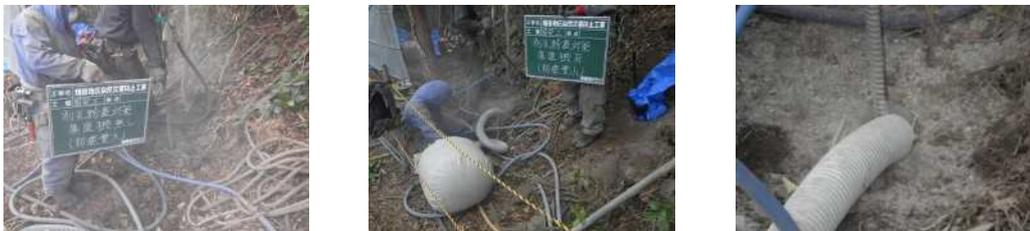
④ 水質汚濁防止の事例：汚濁防止膜の設置や濁水ろ過材の設置などを行っています。
